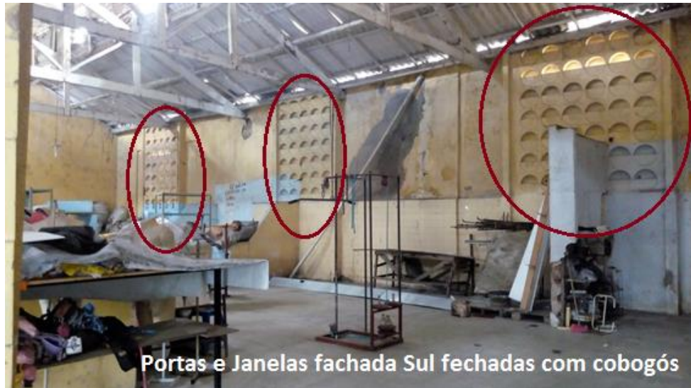
Figura 45 - Interior fachada Sul
